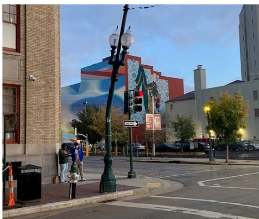
Bent OCS pole
